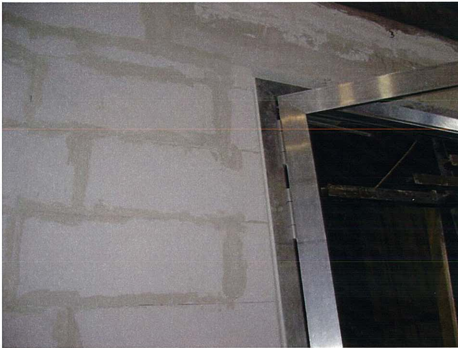
Foto 1 : aanzicht constructie tijdens de inbouw
