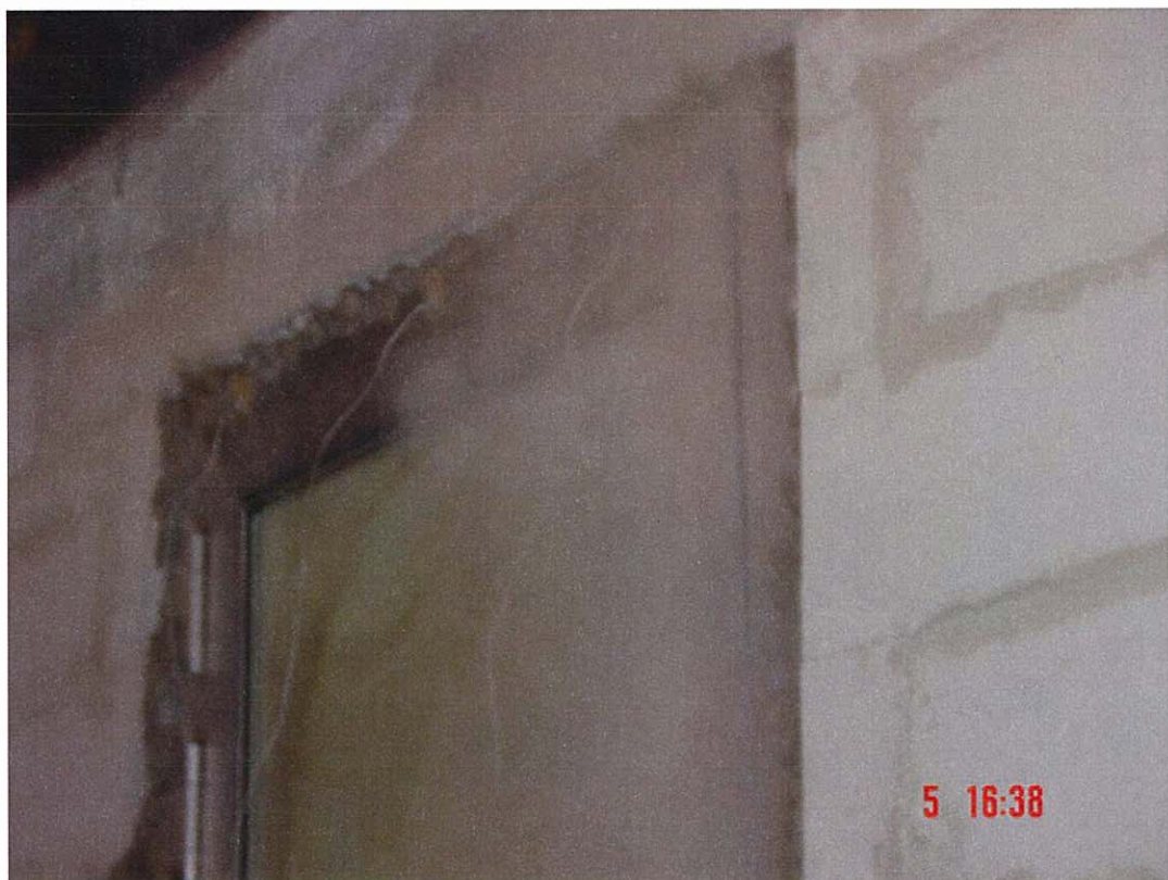
Foto 5 : aanzicht van de constructie na 27 minuten verhitting
