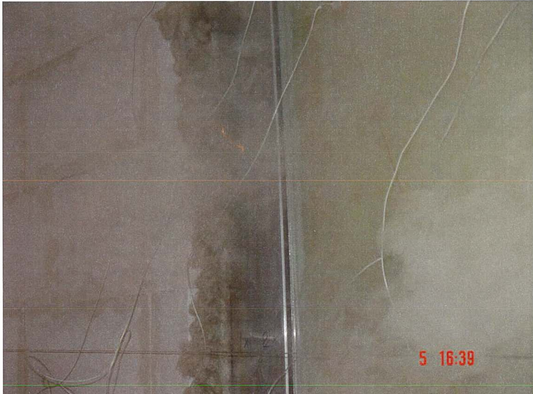
Foto 6 : aanzicht van de constructie na 28 minuten verhitting
