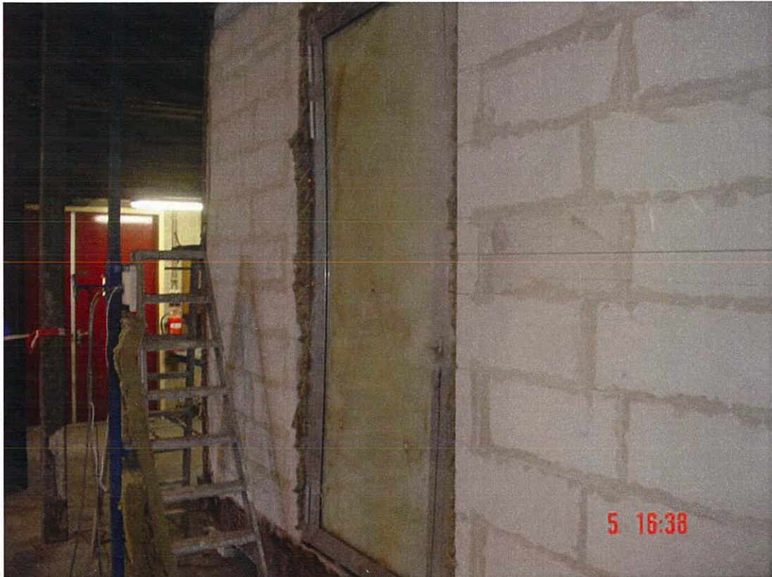
Foto 4 : aanzicht van de constructie na 27 minuten verhitting
