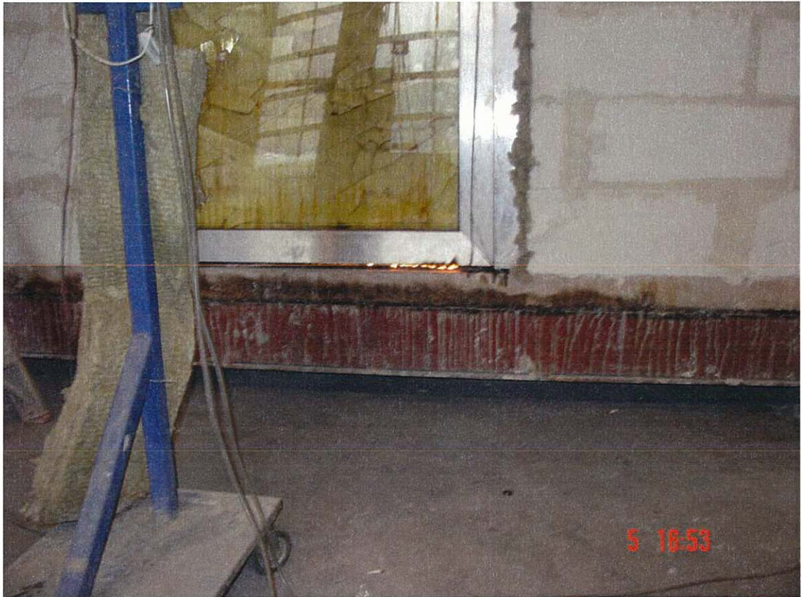
Foto 8 : detail van de constructie na 43 minuten verhitting
